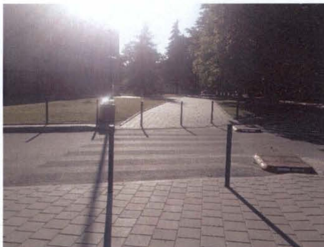
Rysunek 27.2. Słupki na przejściu dla pieszych stanowiące utrudnienie dla osób niewidomych i słabowidzących
