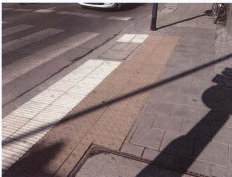
Rysunek 27.5. Osłabienie kontrastu barwnego w wyniku zużycia elementów TGSI (elementy słabej jakości), brak elementów TGSI w pokrywie studzienki
