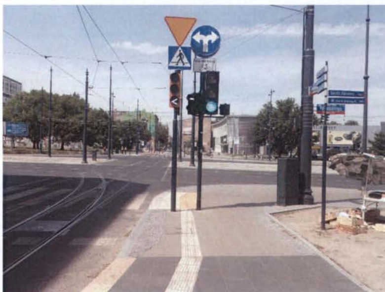
Rysunek 27.9. Nieprawidłowo ustawione słupy przy ścieżce kierunkowej
