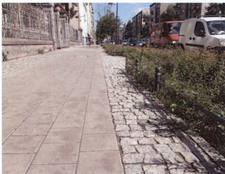
Rysunek 27.7. Prawidłowy sposób ułożenia elementu TGSI z kostki granitowej
