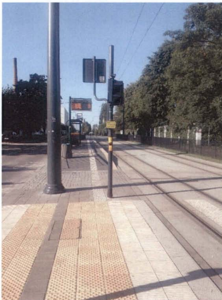
Rysunek 27.10. Nieprawidłowo ustawiony słupek – z każdej strony ścieżki prowadzącej TSGI należy zapewnić 60 cm przestrzeni wolnej od przeszkód.
