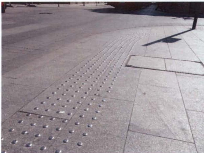
Rysunek 27.8. Stalowe pinezki z gładką powierzchnią mogą powodować poślizgnięcia
