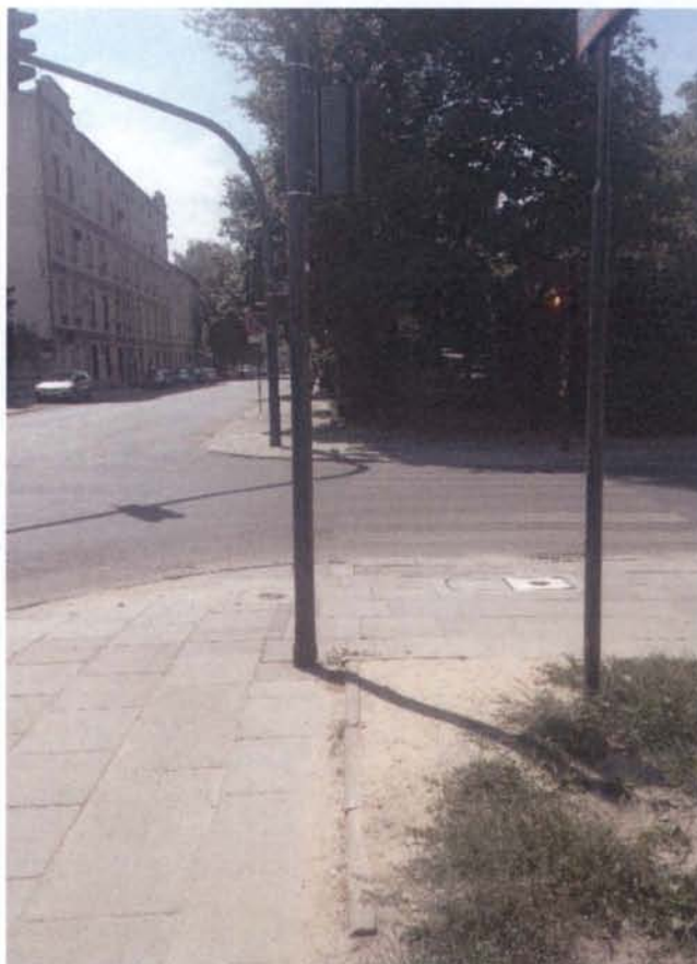
Rysunek 27.1. Słup sygnalizatora umieszczony na trasie ruchu pieszego, stwarzający zagrożenie kolizji dla osoby niewidomej (słup znajduje się tuż przy krawężniku)
