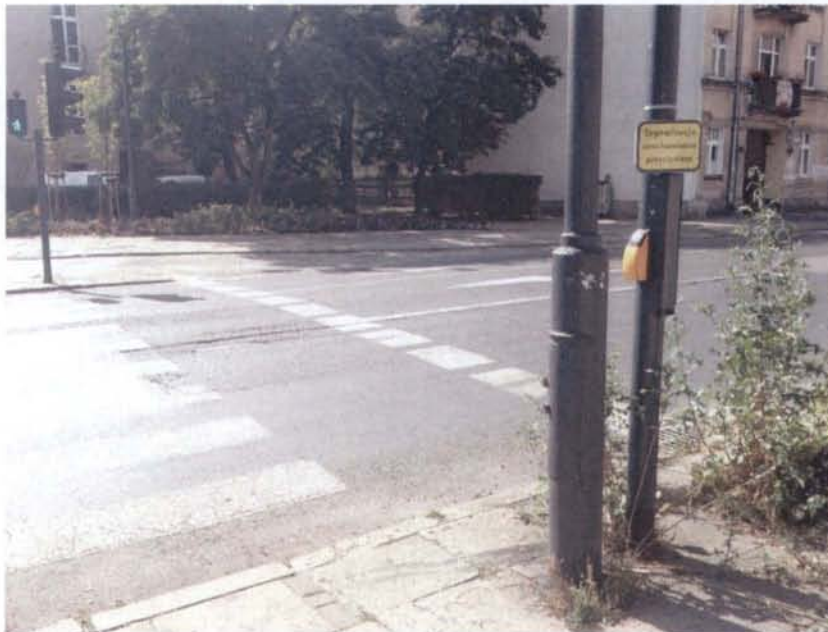
Rysunek 27.12. Przycisk uruchamiający sygnalizację „ukryty” za słupem latarni. Zbyt szybko zakończony zieleniec.
